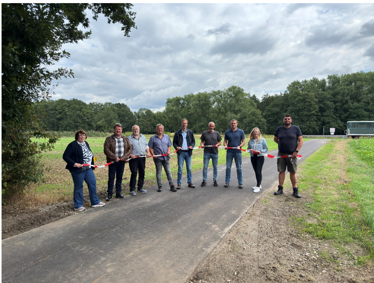
Der neu asphaltierte Straßenabschnitt wurde symbolisch eröffnet. (Foto: Daniel Mäß)
